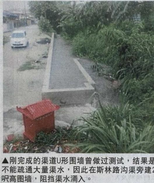
▲刚完成的渠道U形围墙曾做过测试，结果是不能疏通大量渠水，因此在斯林路沟渠旁建2呎高围墙，阻挡渠水涌入。
