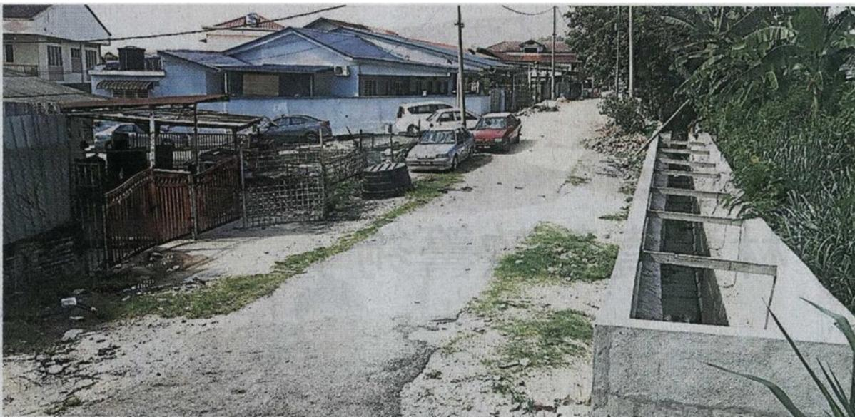
▲渠道築起U形圍牆，防止渠水過高溢出，造成淹水。
